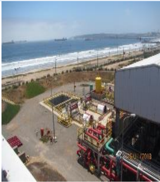
Anexo Imagen 48: Vista aérea (sector Seawell-Basin), de piscinas de aducción y tratamiento de agua de mar para proceso.
