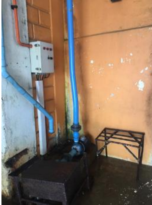
Anexo Imagen 81: Bomba de elevación, desde pozo efluentes del sector producción
