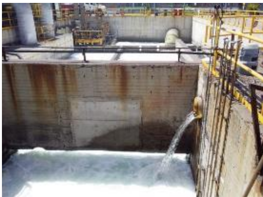
Anexo Imagen 6: Pozo de descarga (pozo sello) de Riles y línea de recirculación.
