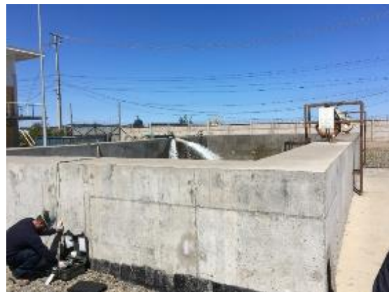
Anexo Imagen 31: Personal de laboratorio Oikos contratado por empresa, instalación de sondas medición in situ, sector pozo de descarga Riles.
