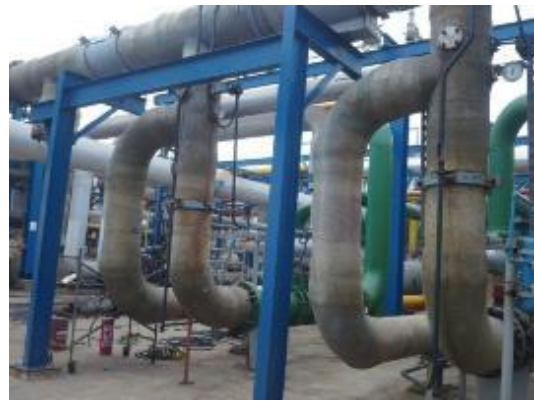
Anexo Imagen 71: Planta (sector costero), con conexiones a intercambiador de calor y salida hacia condensadores.
