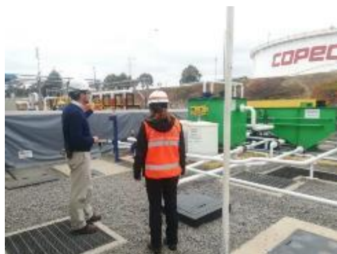
Anexo Imagen 63: Piscina de recepción efluentes encarpetada, sector planta efluentes.
