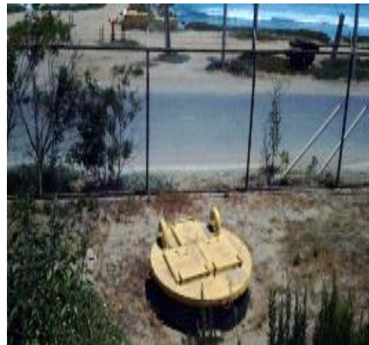
Anexo Imagen 60: Cámara de muestreo de líneas descarga Riles y Aguas servidas.
