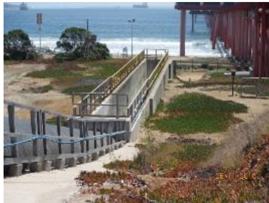
Anexo Imagen 50: Visita a sector “canal abierto”, con descarga de aguas de procesos y Riles
