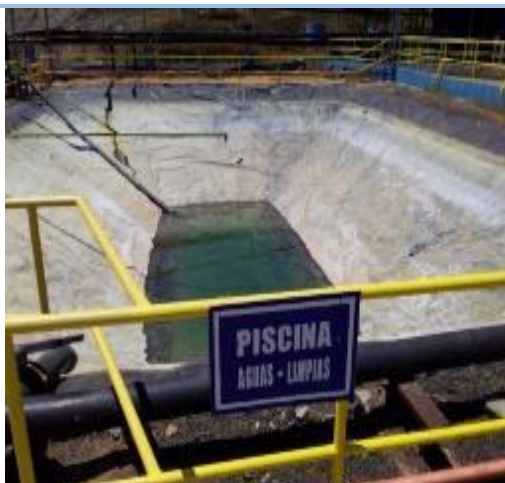
Anexo Imagen 34: Piscina de "aguas limpias" con efluentes tratados, con bajos niveles de acumulación y sin descarga.
