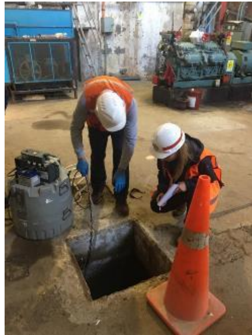
Anexo Imagen 74: Inicio de instalación de sonda de pH-T° y cable muestreador.
