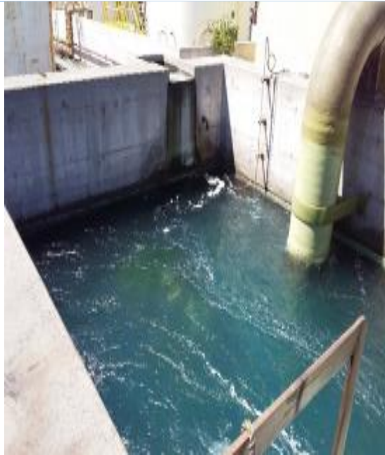
Anexo Imagen 26: Pozo de sello, con flujo laminar de descarga de Riles.
