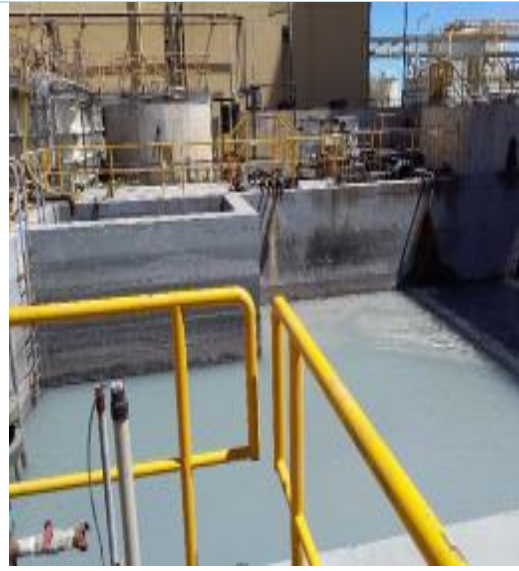
Anexo Imagen 23: Piscinas de recepción efluentes de procesos, planta Riles (WWT)
