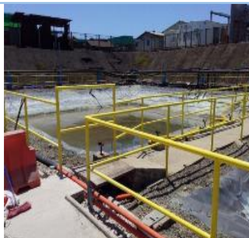
Anexo Imagen 35: Vista colateral de piscina TK-32B - PAC
