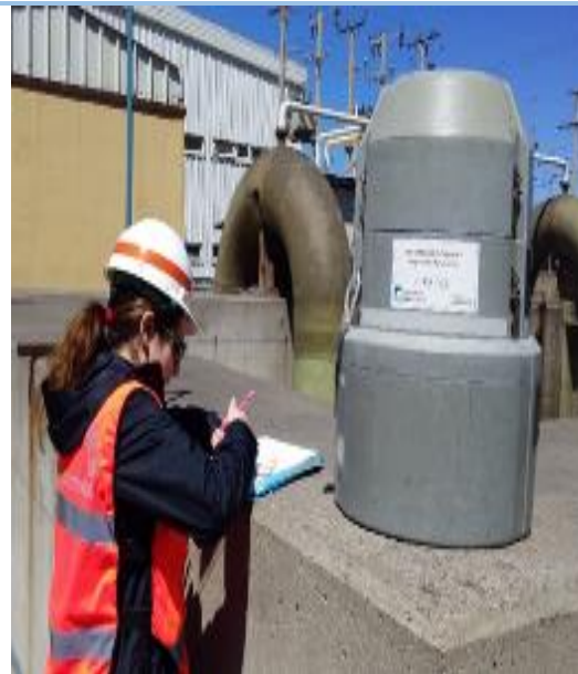
Anexo Imagen 29: Equipo de monitoreo instalado, en sector pozo descarga.
