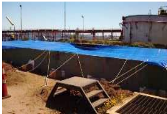
Anexo Imagen 52: Piscina de decantación de efluentes, vaciada y cubierto con lona.
