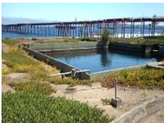
Anexo Imagen 53: Piscina de aguas lluvias limpias. (sin bombeo a planta)
