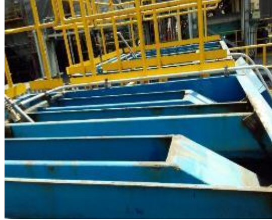
Anexo Imagen 15: Agitadores con filtro Lamella.
