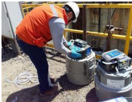
Anexo Imagen 7: Instalación de equipo de muestreo, costado pozo sello de descarga.
