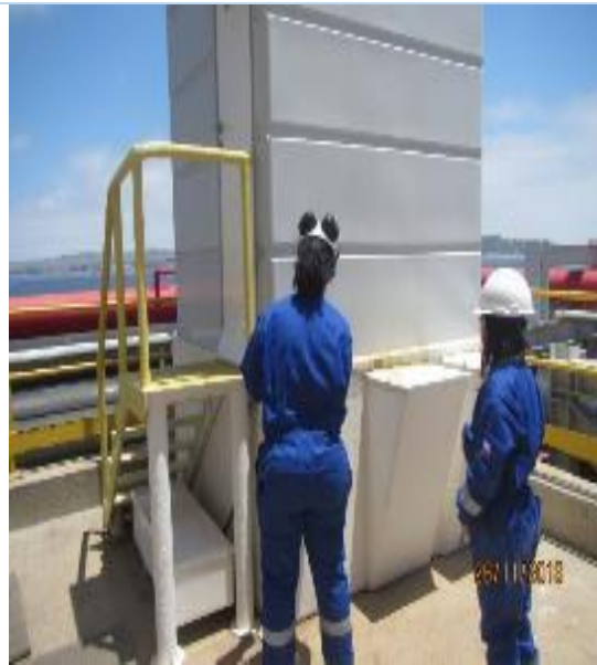
Anexo Imagen 49: Visita de inspección de baño modular en muelle.
